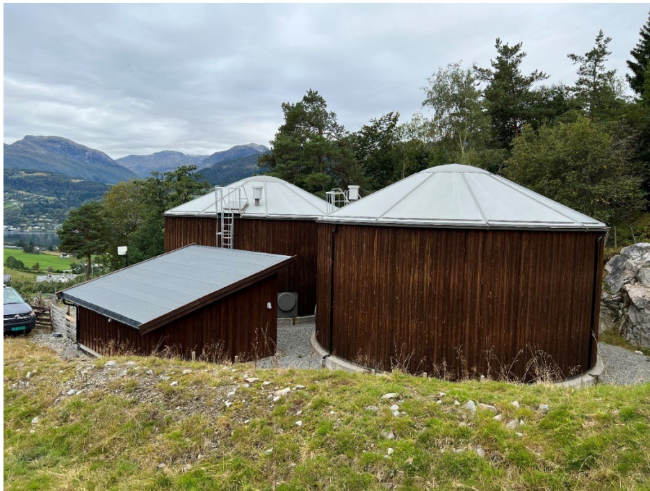
Figur 6 Nye Øydve høgdebasseng vart etablert i 2018. Høgdebassenget består av to separate basseng på 350m 3 kvar og eit felles ventilkammer. Høgdebassenga er bygd av glasfiber og kledd med trepanel. To separate høgdebasseng gir god forsyningstryggleik og enkel drift og vedlikehald (t.d. ved innvendig vasking av bassenga).
