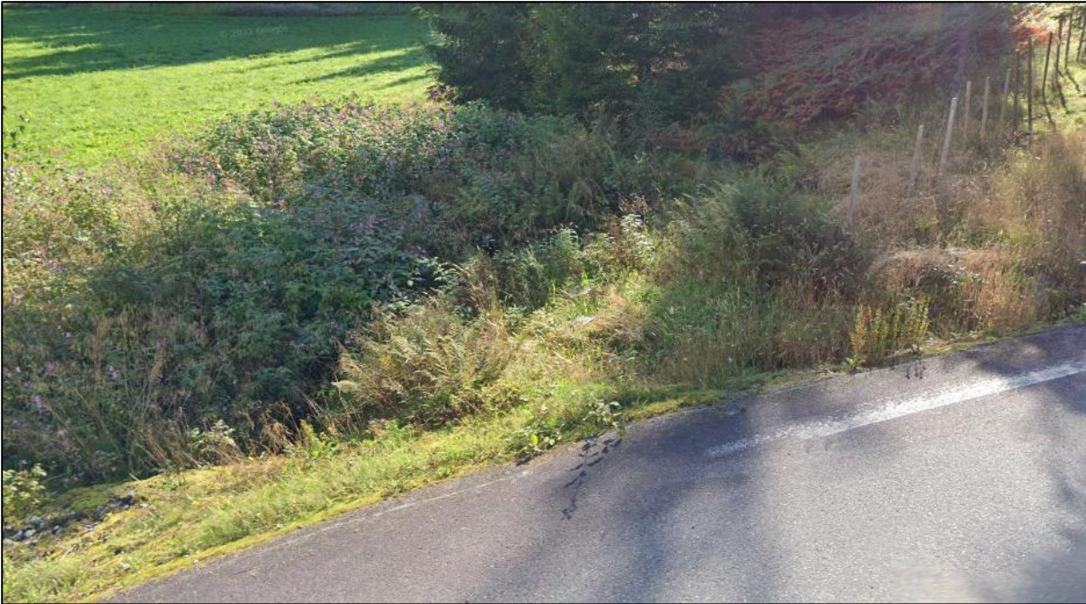
Figur 7-2. Innløp bekkelukking under Hjeltnesvegen, vist som bekkelukking1 i Feil! Fant ikke referanseilden.. Bilde fra google street view (aug. 2022).
