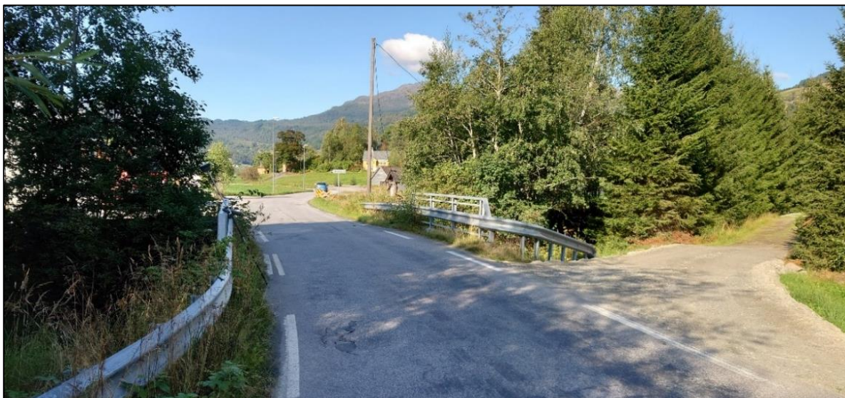
Figur 2-3 Fylkesveg 5376 Hjeltnesvegen og brua over Gauro.
