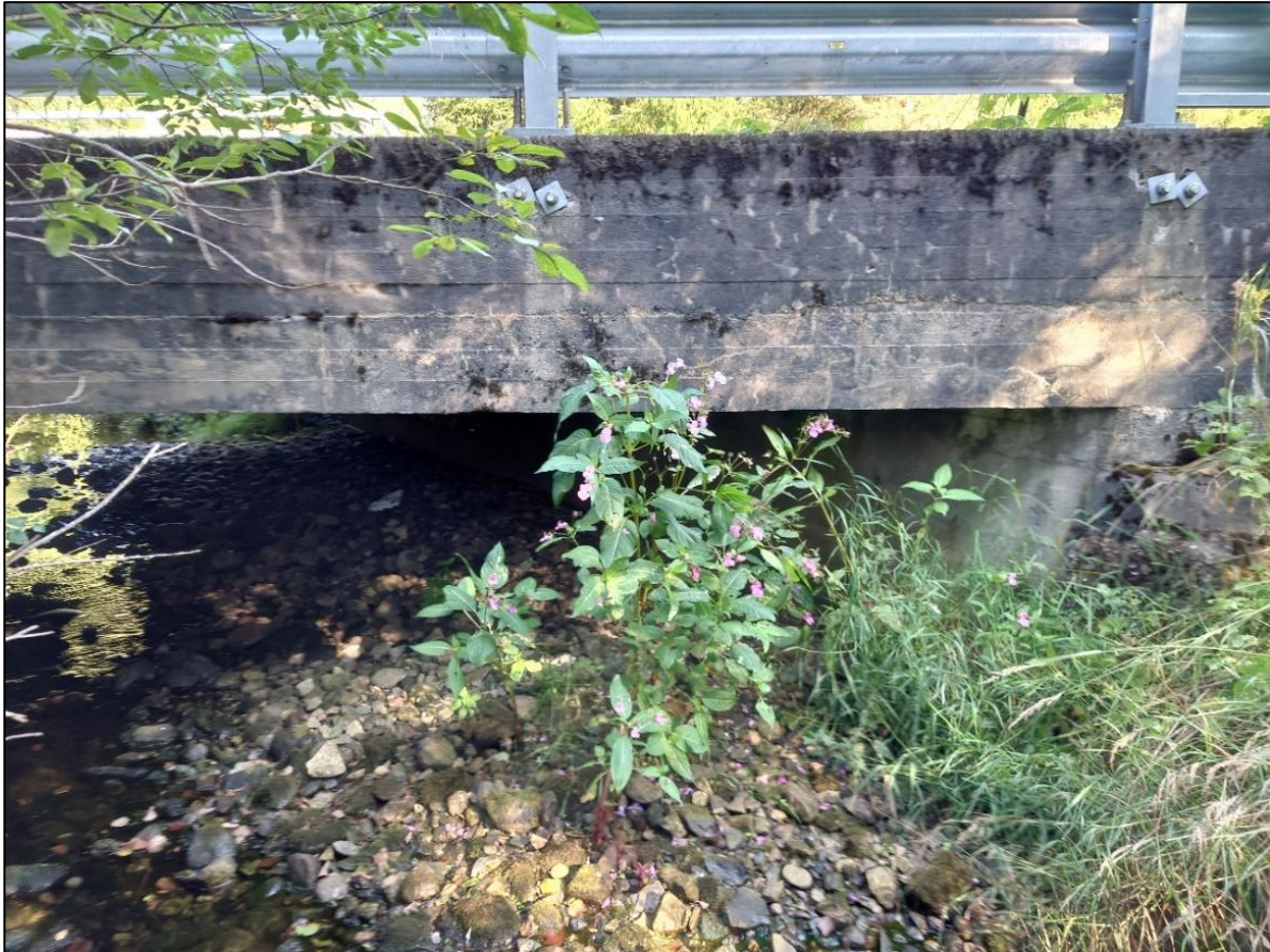
Figur 2-4 Detalj som viser litt av lysopninga under brua og utfordringene med avlagring av masser under brua.
