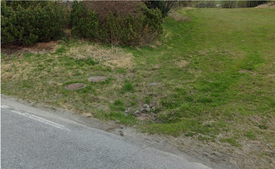
Figur 7-4. Sluk nederst på jordet i flomvei, vist som Sluk1 i Figur 7-1.. Bilde fra google street view (mai 2023).
