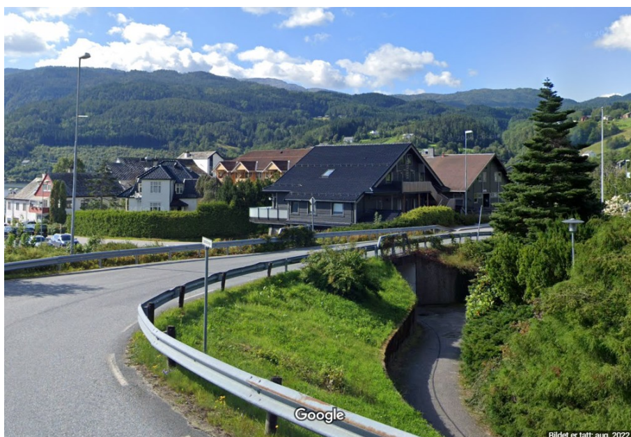
Figur 2-12: Fotgjengarundergang under fv. 572 i Brakanes sentrum. Foto: Google Street View.
