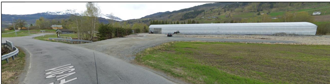
Figur 4-5 Aust for elva Gauro ligg det nye veksthus. Ny avkøyrsla til tomte er opparbeidd (Kjelde: Google maps).
