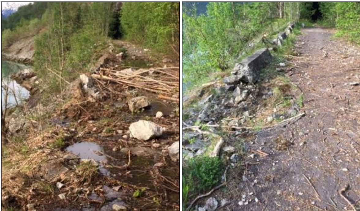
Figur 7. Tilstanden på gamlevegen, truleg nær gamle Ljoraskreo tunnelen (aust). FOTO: privat
